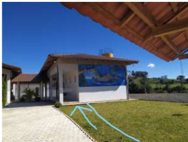
Imagem do espaço que receberá a rampa para promover a acessibilidade
