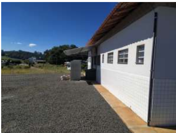
Imagem de parte externa da Escola
